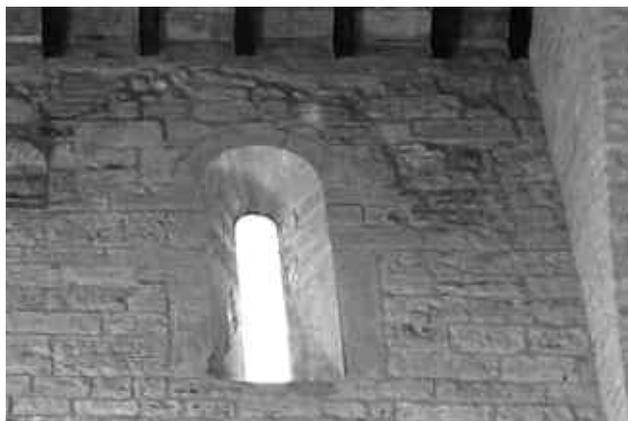
Fig. 26. Sezione di muratura interna all'altezza della seconda monofora nord della navata centrale. L'immagine mostra con chiarezza l'inserimento in spaccatura dei mensoloni di pietra.
