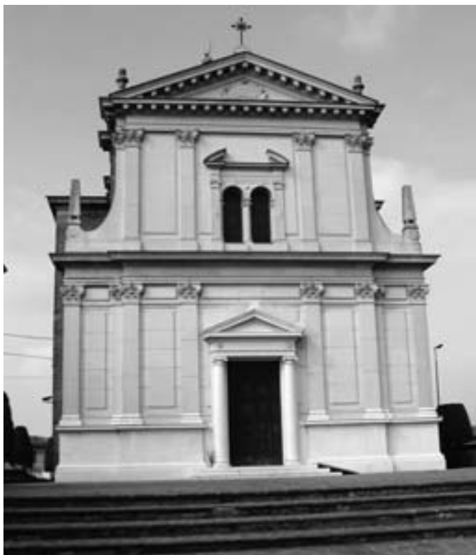
■ Crezzano, chiesa parrocchiale di S. Giorgio
